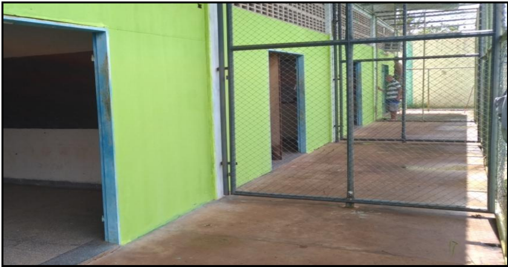
Figura 04 - Detalhes das divisórias entre as entradas das salas de aula
